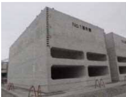
大分県 佐賀関漁港 (ケーソン製作時)
