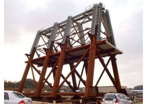
長崎県 阿翁浦漁港 (ジャケット製作時)
