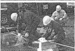
給水管の漏水応急復旧に驚きの声
